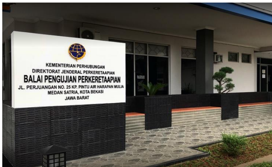
Gambar II.1. Tampak Depan Balai Pengujian Perkeretaapian
