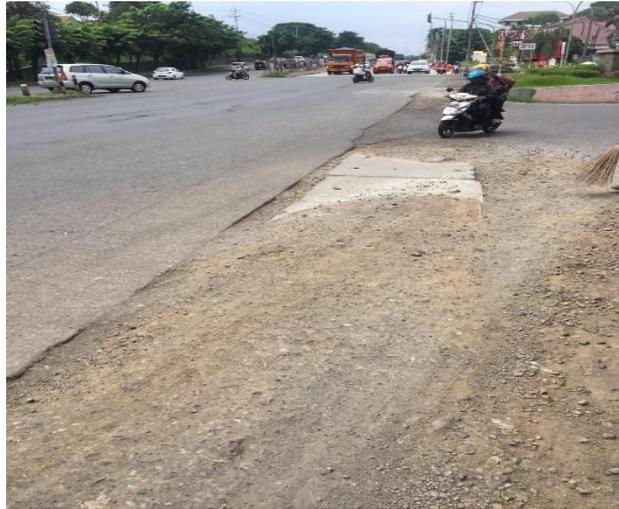
**Gambar II. 14** Bahu Jalan tidak dibuat dengan perkerasan jalan
