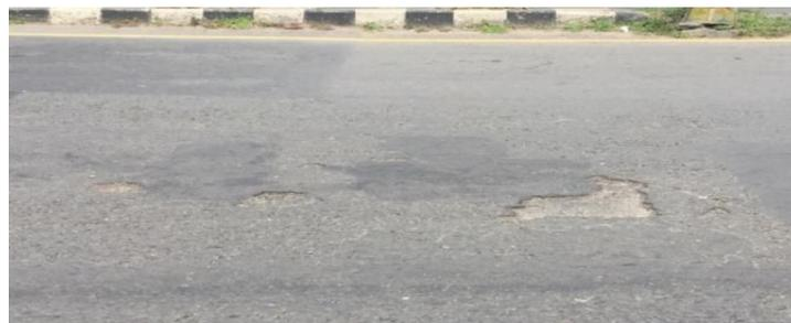
**Gambar II. 2** Perkerasan Jalan Yang Rusak
