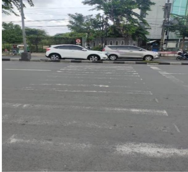
**Gambar II. 4** Marka Jalan yang pudar
