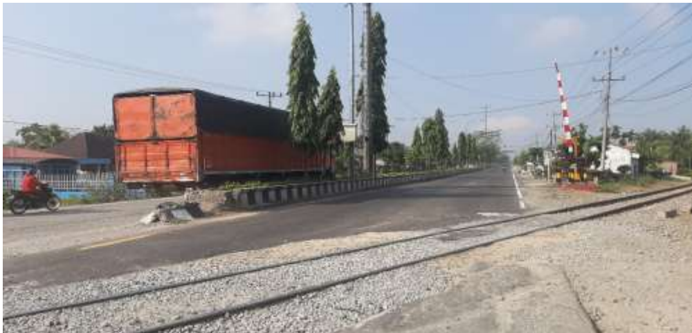
Gambar V. 24 Kondisi Perlintasan Sebidang Tahun 2020
