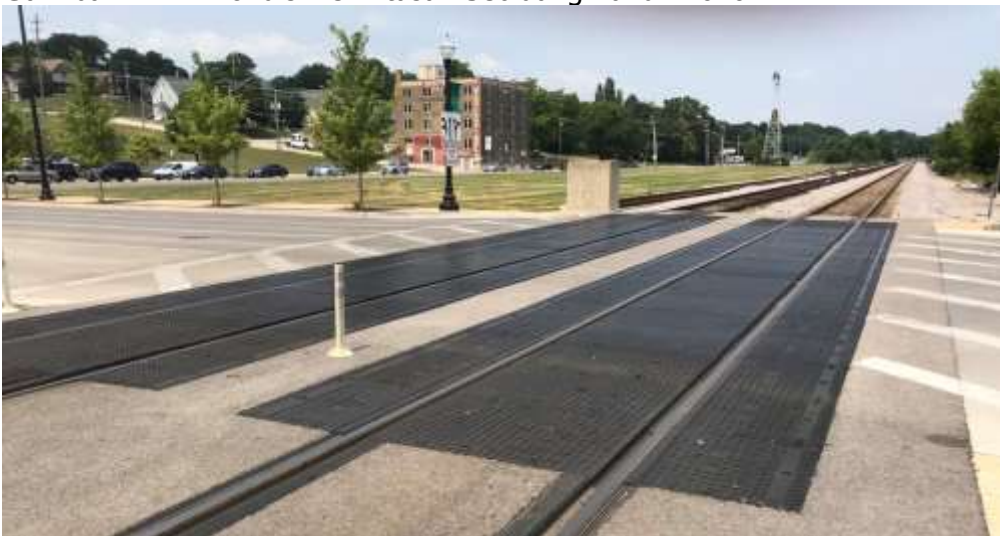
Gambar V. 25 Perlintasan Dengan Bahan Karet Penuh ( Full Depth Rubber ) Sumber: Kentucky Transportation Center, 2015
