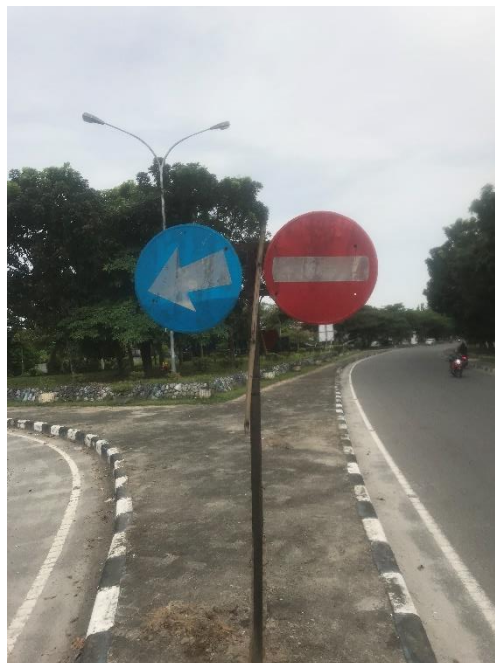
Gambar II. 8 Kondisi Rambu Di Jalan Sultan Serdang - KNO KM 10 - 11,4
