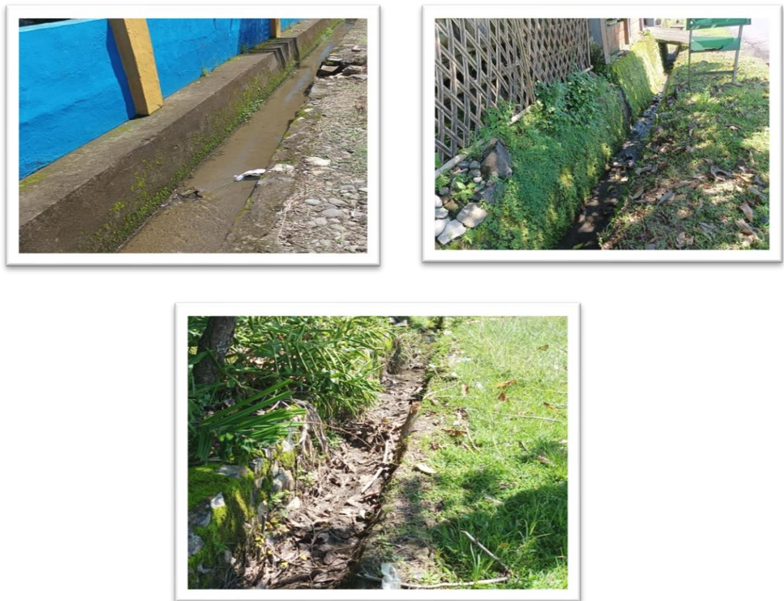
Gambar V. 34 Kondisi Eksisting Saluran Tepi Jalan Kajang – Sinjai II
