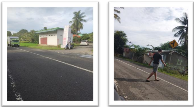
Gambar V. 22 Kondisi Marka dan Lalu Lintas Kendaraan Tidak Bermotor Segmen 5 Kondisi lalu lintas tidak bermotor pada segmen 5 tidak memiliki lintasan penyebrangan dan lajur pejalan kaki sehingga pejalan kaki yang menyusuri pada segmen 5 berjalan di bahu dan badan jalan. Kondisi rambu pada segmen 5 sudah memenuhi standar laik jalan. Kondisi marka pemisah jalan dan marka tepi pada segmen 5 sudah memudar. Tiang listrik yang ada pada segmen 5 penempatannya sudah memenuhi standar laik jalan.
