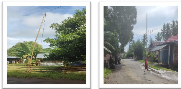
Gambar V. 31 Kondisi Tiang Listrik dan Lalu Lintas Tak Bermotor Segmen 8
