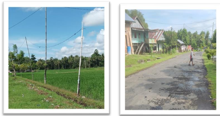
Gambar V. 28 Kondisi Tiang Listrik dan Lalu Lintas Tak Bermotor Segmen 7
