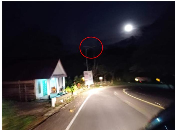
**Gambar II. 18** Kondisi Lampu Tidak Berfungsi Pada Tikungan KM 20 + 630
