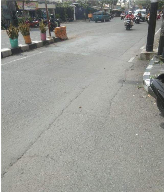
**Gambar II. 4** Kondisi permukaan jalan yang tidak rata
