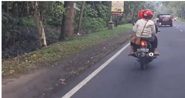
GAMBAR V. 11 Kondisi Eksisting Bahu Jalan KM 2
