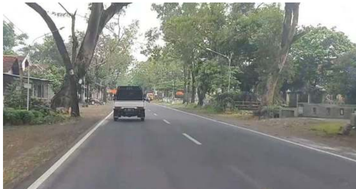
GAMBAR V. 10 Kondisi Eksisting Jalan KM 2
