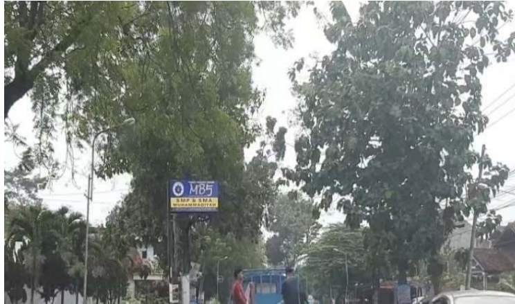
GAMBAR V. 19 Kondisi Eksisting Lampu Penerangan Jalan KM 3
