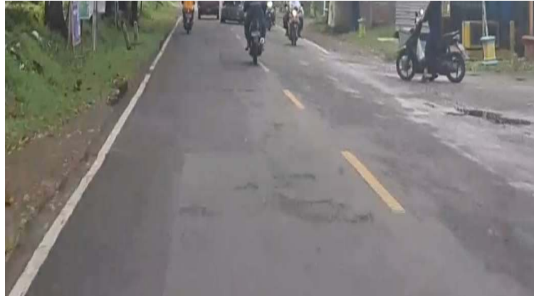
GAMBAR V. 12 Kondisi Eksisting Marka Jalan KM 2
