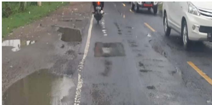
GAMBAR V. 6 Kondisi Eksisting Marka Jalan KM 1
