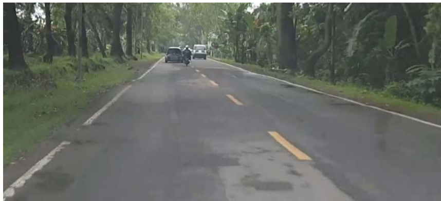
GAMBAR V. 4 Kondisi Eksisting Jalan KM 1
