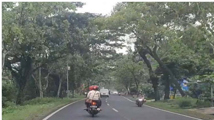
GAMBAR V. 7 Kondisi Eksisting Lampu Penerangan Jalan KM 1
