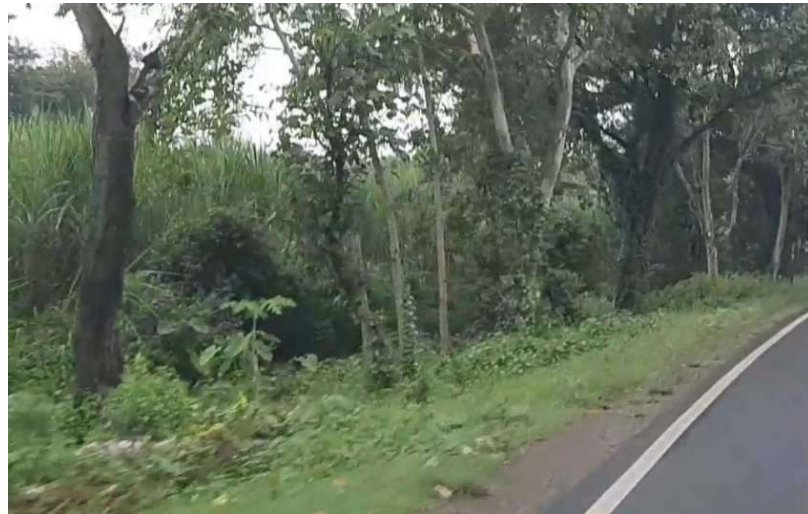
GAMBAR V. 5 Kondisi Eksisting Bahu Jalan KM 1
