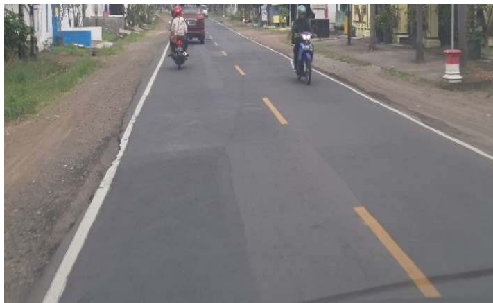
GAMBAR V. 18 Kondisi Eksisting Marka Jalan KM 3
