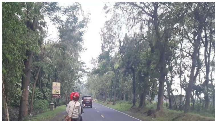
GAMBAR V. 13 Kondisi Eksisting Lampu Penerangan Jalan KM 2
