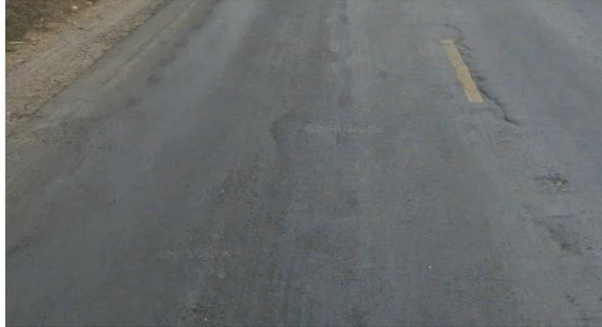
**Gambar V. 41** Perkerasan Jalan yang Bergelombang
