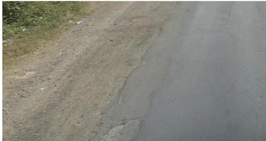
**Gambar V. 42** Perkerasan Pinggir Jalan yang Tidak Rata
