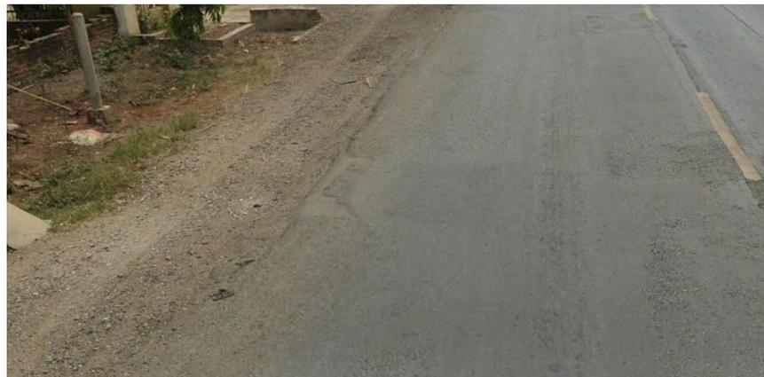
**Gambar V. 40** Perkerasan Pinggir Jalan yang rusak Segmen 1
