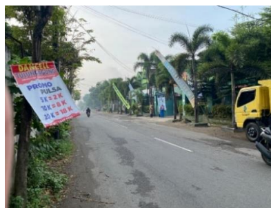
Gambar II. 14 Kondisi Jalan Ki Mangun Sarkoro
