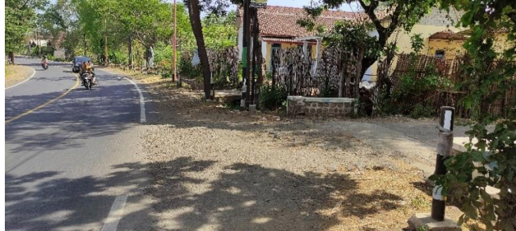
Gambar 5. 7 Kondisi Tikungan Situbondo 1
