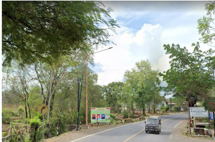
Gambar 5. 11 Lampu Penerangan Jalan Tikungan Situbondo 1
