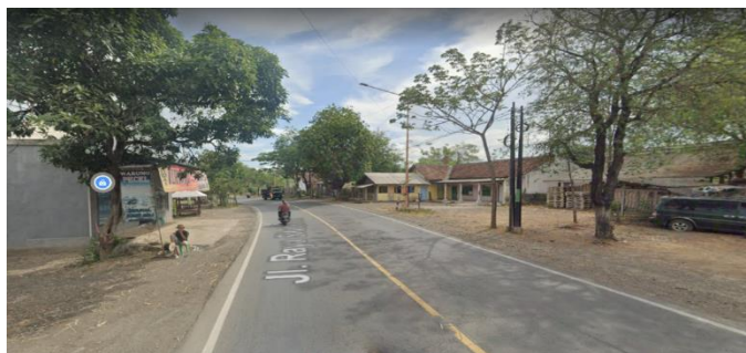
Gambar 5. 3 Bahu Jalan Kanan dan Kiri Tikungan Situbondo 1
