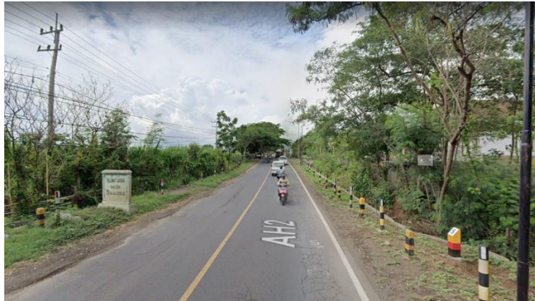
Gambar 5. 4 Bahu Jalan Kanan dan Kiri Tikungan Situbondo 2
