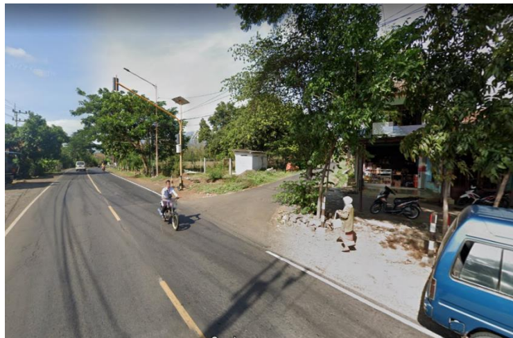
Gambar 5. 8 Kondisi Tikungan Situbondo 2
