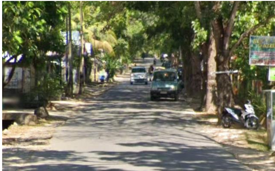
Gambar V.40 Kondisi Eksisting Jalan Balai Kota III
