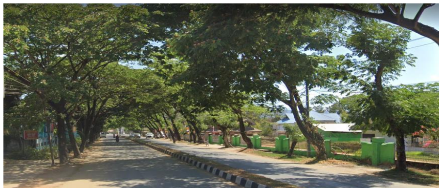
Gambar V.36 Kondisi Eksisting Jalan Sao-Sao
