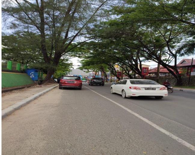
Gambar V.35 Kondisi Eksisting Jalan Ahmad Yani
