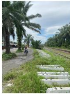
Gambar V. 2 Kondisi Jalan Raya Dekat Dengan Jalur Rel
