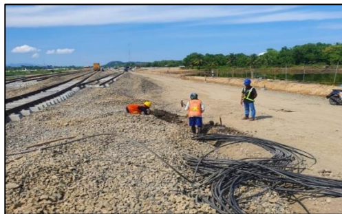
Gambar II.4 Pengerjaan galian sintel
