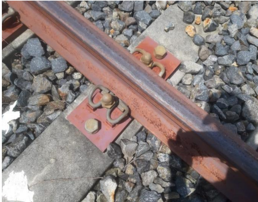
Gambar II. 6 Penambat jenis Fastclip (Kupu-kupu)
