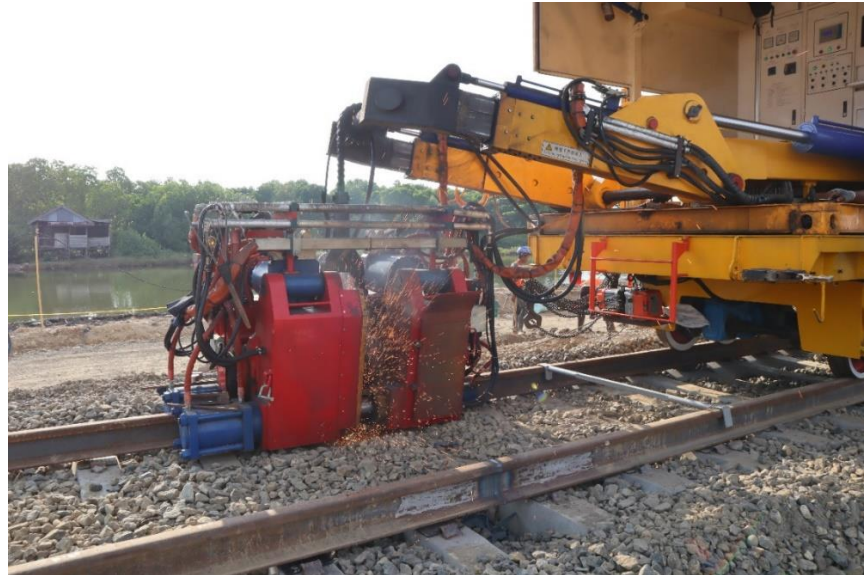
Gambar III. 4 Las Flashbutt
