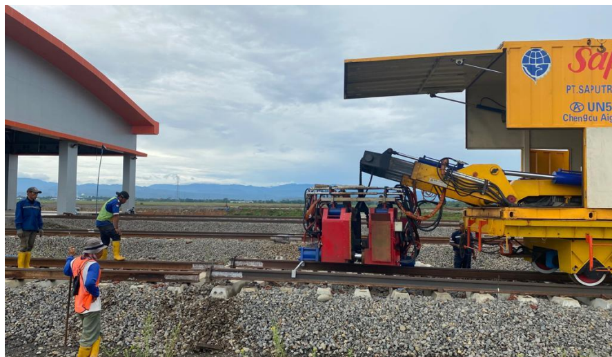
Gambar V. 4 Proses Pengerjaan Metode Flashbutt
