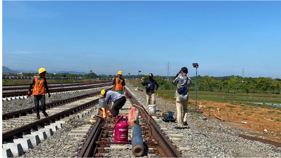
Gambar V. 3 Proses Pengerjaan Metode Thermit
