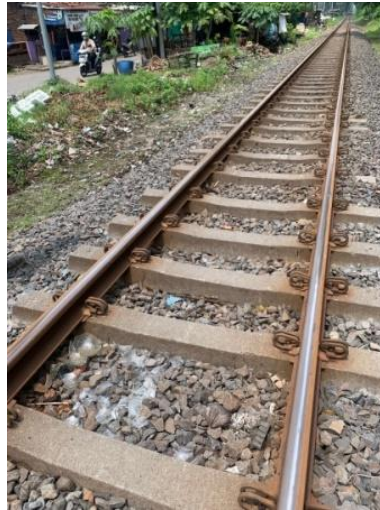
Gambar V. 6 Balas Kurang Pada Lintas KM 28 + 221
