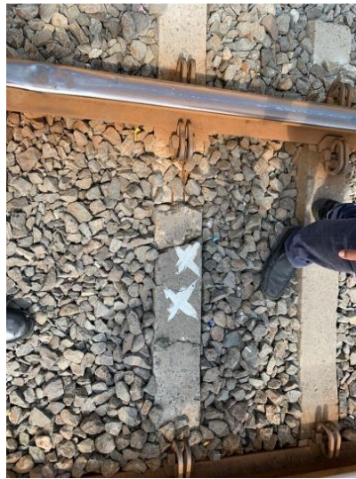
Gambar II. 6 Bantalan Beton Pecah KM 25 + 308 Lintas Sidoarjo – Porong
