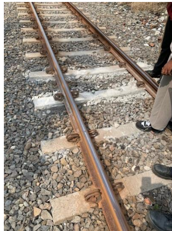
Gambar V. 9 Mud Pumping Pada KM 25 + 666
