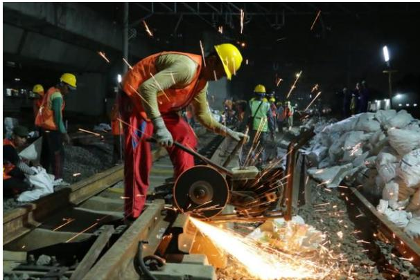
**Gambar II. 22** Pemotongan rel
