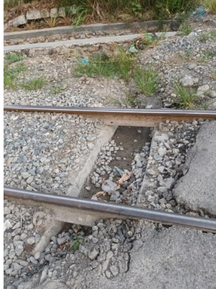
Gambar II. 7 Kondisi Mud Pumping KM 4+878 Lintas Bukit Putus-Pauh Lima
