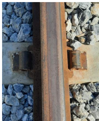
Gambar II. 5 Penambat E-Clip Hilang di KM 4+664
