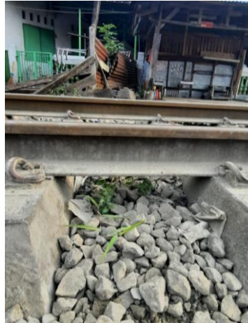
Gambar II. 6 Kondisi Balas Kurang KM 2+678 Lintas Bukit Putus-Pauh Lima
