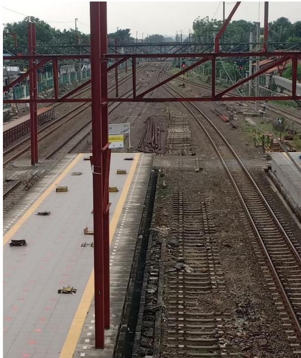
**Gambar II. 3** Lengkung S Curve Nomor 15C dan 15D KM 33<sup>+388</sup> – KM 33<sup>+594</sup>
