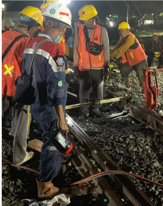
Gambar V. 12 Pemeriksaan lebar sepur menggunakan Matisa
