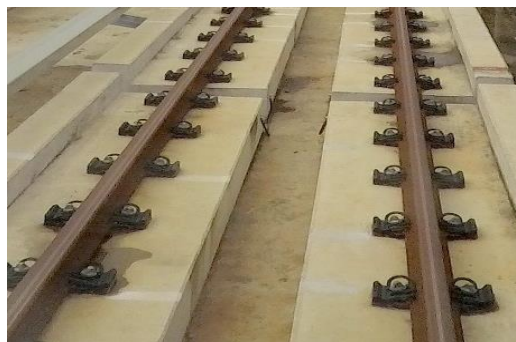
Gambar II. 7 Bantalan pada lintas LRT
