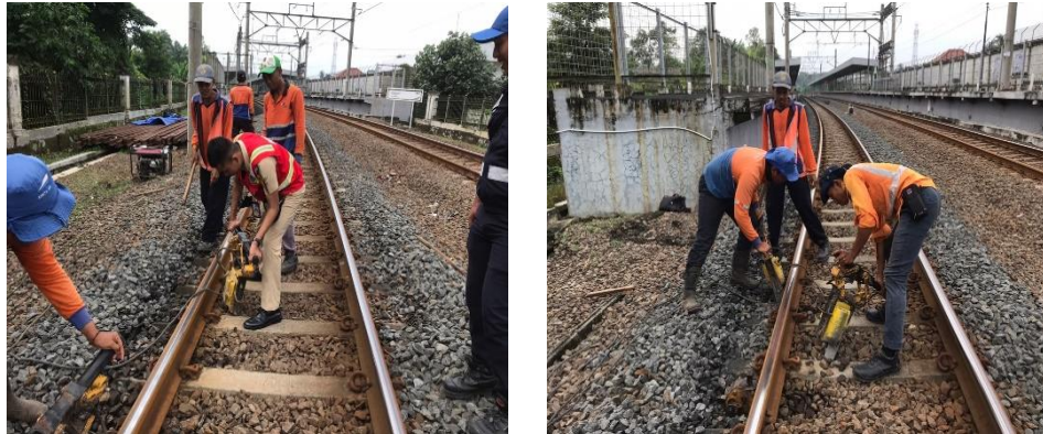
Gambar III.4 Penggunaan alat Hand Tie Temper pada Lengkung
