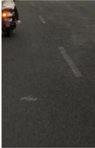
Gambar : Visualisasi Marka Membujur Garis Putus-Putus Pembagi Lajur Pada Ruas Jalan Kaliurang KM 4 – KM 5,6 di Kabupaten Sleman
