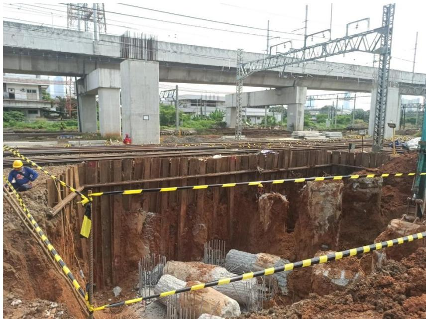
**Gambar V. 11** Galian Tanah Struktur Pile Cap
