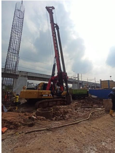
**Gambar V. 16** Pekerjaan *Bored Pile*
