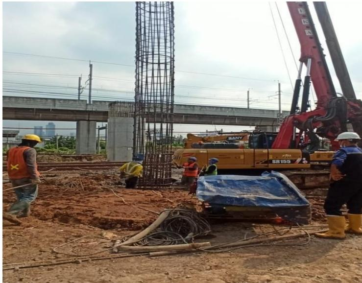
**Gambar V. 7** Pemasangan Besi Tulangan Bored pile
