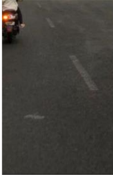
Gambar 5.4 : Visualisasi Marka Membujur Garis Putus-Putus Pembagi Lajur Pada Ruas Jalan Kaliurang KM 4 – KM 5,6 di Kabupaten Sleman
