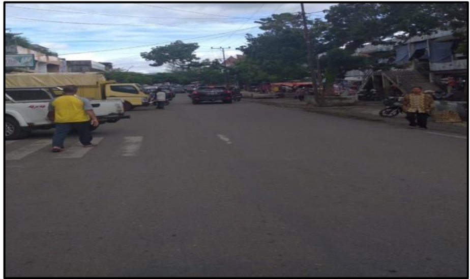
Gambar 2. 7 Kondisi Jalan Lettu Hamid II
