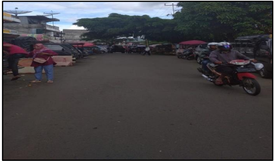
Gambar 2. 9 Kondisi Jalan Lettu Hamid III
