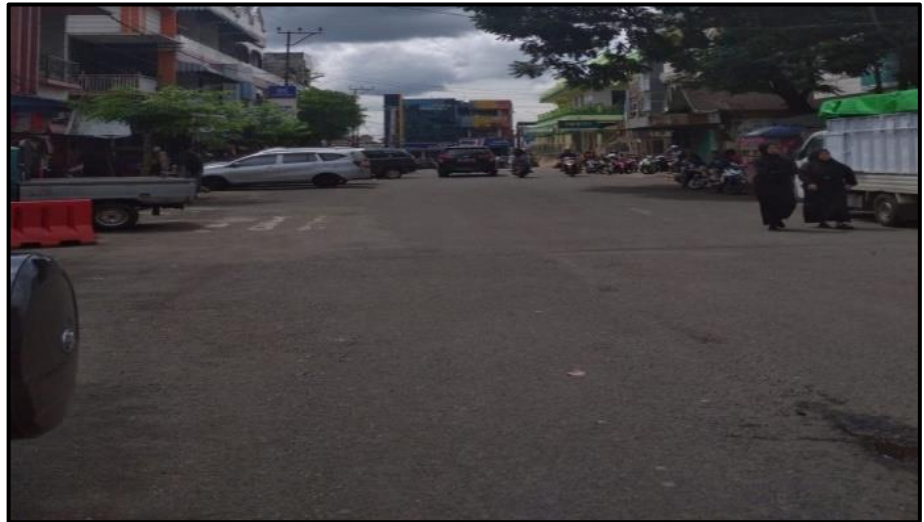
Gambar 2. 13 Kondisi Jalan Peltu Menalis I
