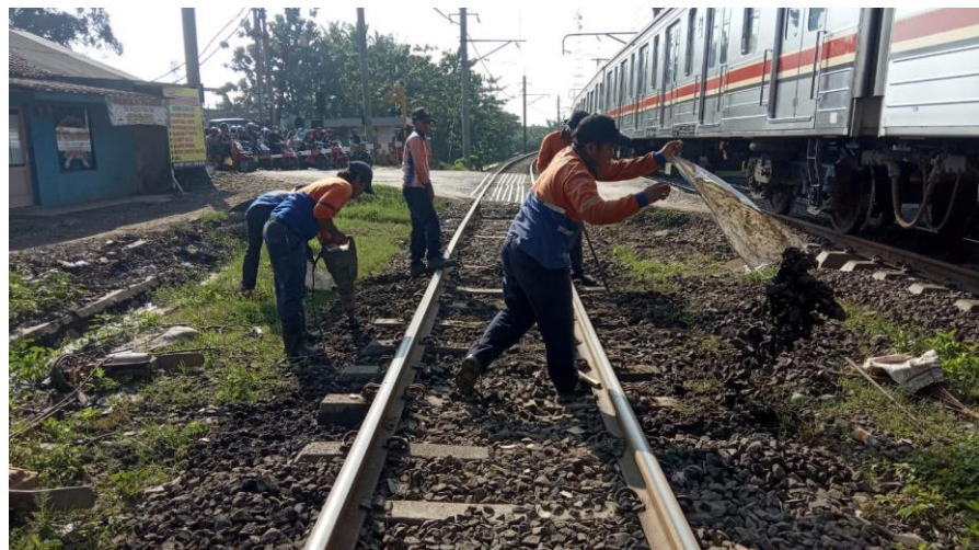
Gambar V.6 Proses Pembuangan Balas Kotor
