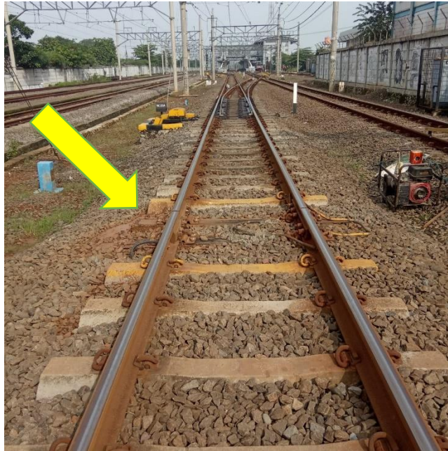
Gambar II.7 Kondisi Eksisting Mud Pumping pada Sambungan Rel di KM 30+300 s/d 30+400
