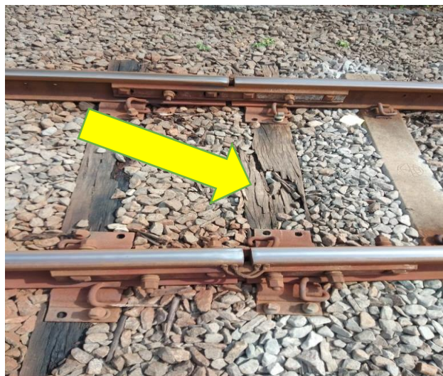
Gambar II.4 Kondisi Eksisting Bantalan Kayu Lapuk di KM 30+000 s/d 30+100
