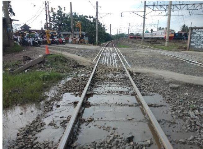
Gambar III.8 Pemompaan Lumpur di KM 32+500 s/d 32+600 lintas Serpong-Cisauk
