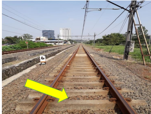
Gambar II.5 Kondisi Eksisting Ballas Kurang di KM 31+900 s.d 32+200
