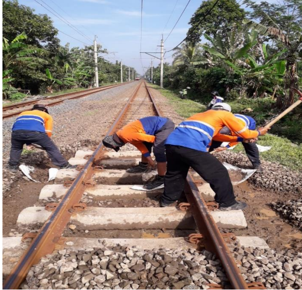
Gambar V.3 Proses Pengerukan Balas Mati pada KM 30+300
