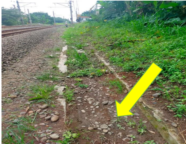
Gambar II.6 Kondisi Eksisting Drainase tertutup tanah di KM 30+500 s/d 30+900
