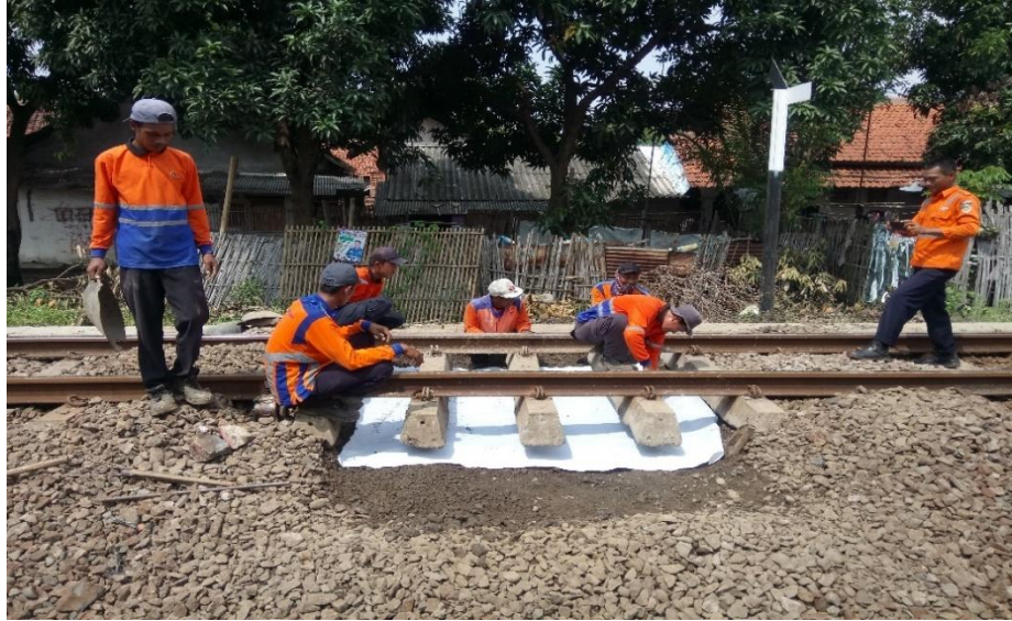
Gambar V.10 Proses Pemasangan Geotekstil Pada Jalan Kereta Api
