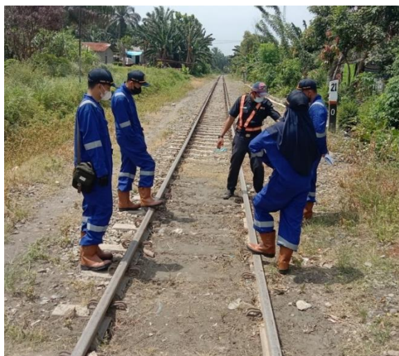
Gambar V. 23 Mud Pumping lintas Teluk Dalam – Pulu Raja Km 21-150
