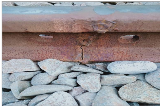
Gambar V. 1 Rel retak Teluk Dalam - Pulau Raja KM 25+500
