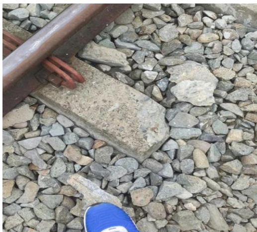
Gambar V. 4 Bantalan beton rusak di lintas Teluk dalam – Pulu Raja
