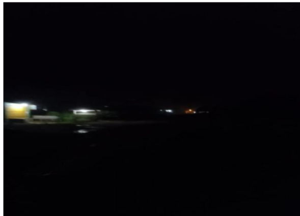
Gambar V. 3 Kondisi Jalan tidak terdapat PJU
