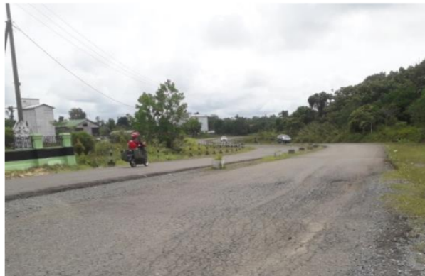
Gambar V. 4 Kondisi perkerasan jalan yang tidak rata
