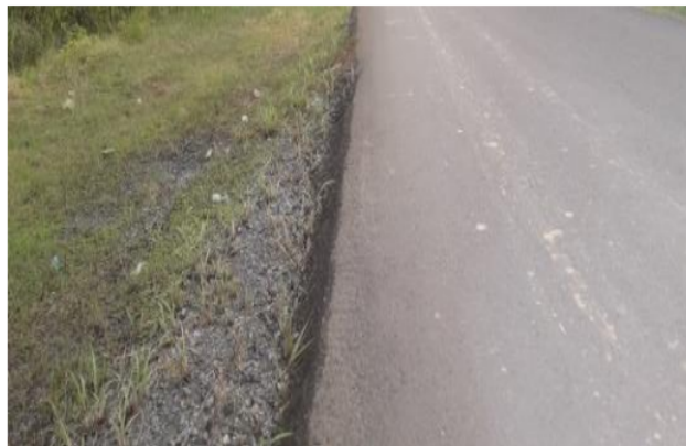
Gambar V. 4 Kondisi perkerasan jalan yang tidak rata
