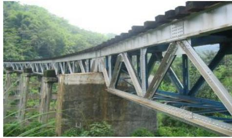
**Gambar 3.6** Jembatan Rasuk Rangka.
