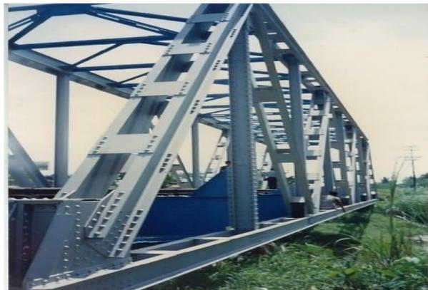
**Gambar 3.10** Jembatan Dinding Rangka Tertutup lantai lintas bawah.
