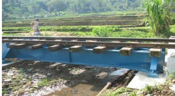
**Gambar 3.3** Jembatan Rasuk Profile Atau Dlurung.
