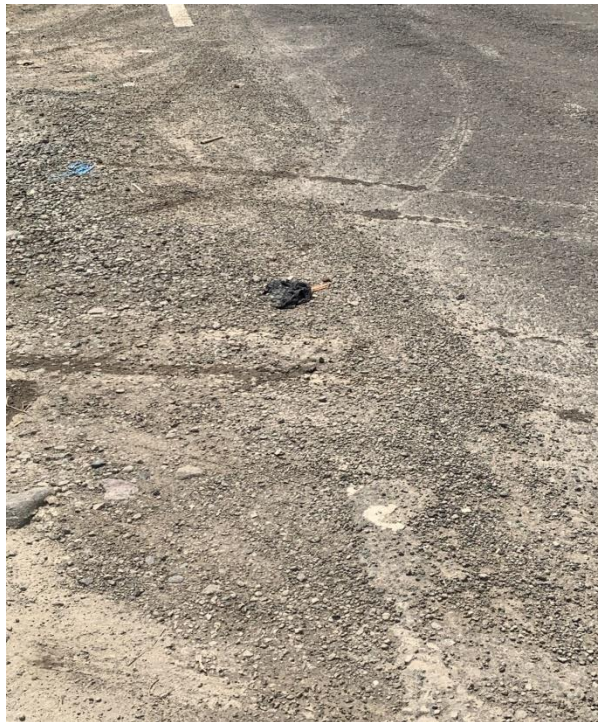
Gambar V. 4 Kondisi Bahu Jalan yang berpasir
