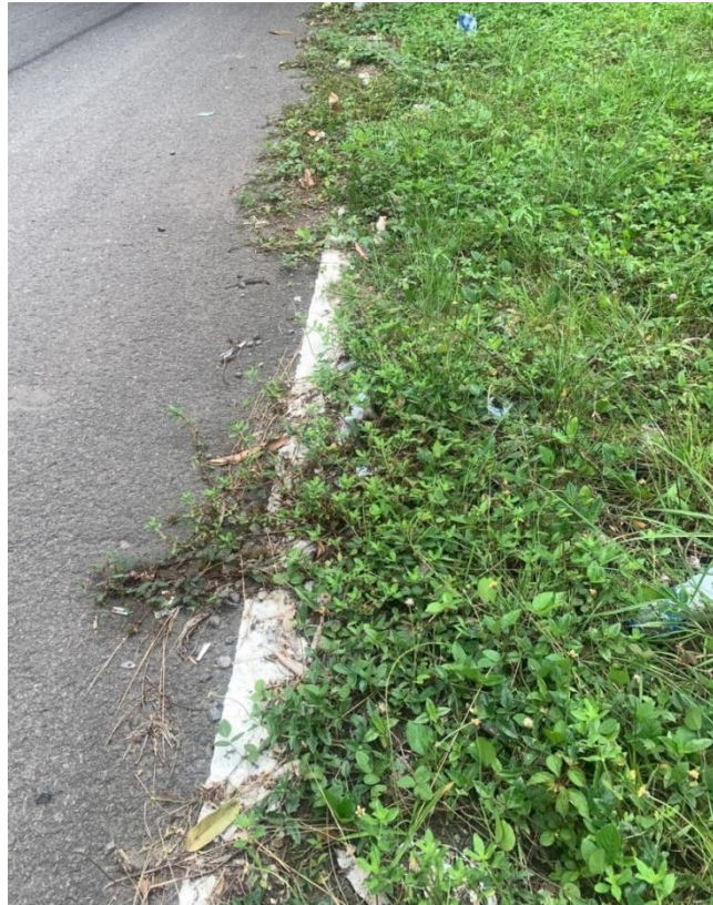
Gambar V. 6 Marka jalan yang sudah pudar
