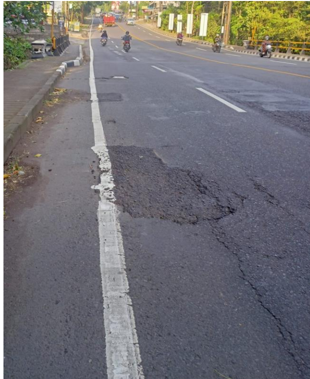
Gambar V. 4 Kondisi Perkerasan Jalan
