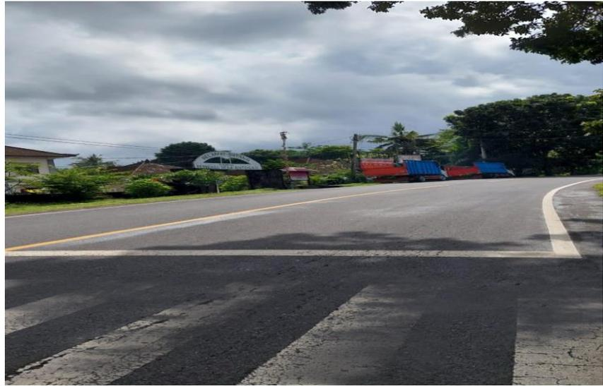
**Gambar II. 3** Kondisi Marka pada Ruas Jalan Antosari
