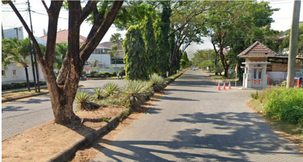
Gambar II. 23 Kondisi Eksisting Jalan Cemara Raya
