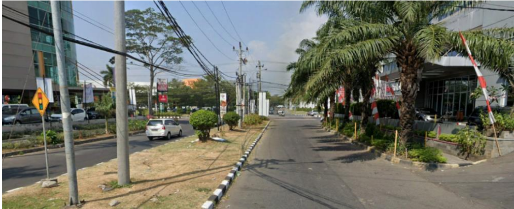
Gambar II. 17 Kondisi Eksisting Jl. Hartono Mall 2
