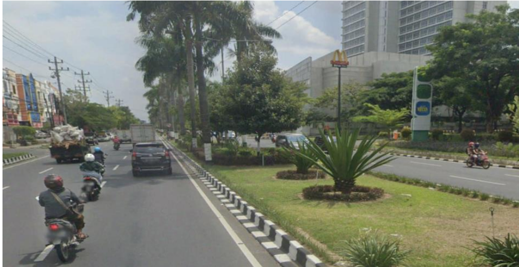
Gambar II. 19 Kondisi Eksisting Jalan Ir Soekarno 3
