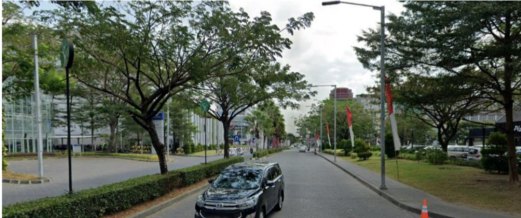
Gambar II. 15 Kondisi Eksisting Jl. Hartono Mall 1
