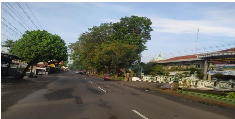
Gambar 7 Kondisi Jalan KH. Wahid Hasyim I di Depan SD Unggulan Aisyiyah
