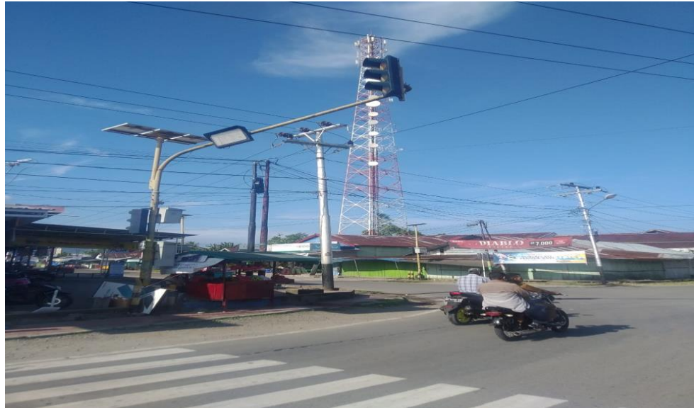
Gambar II. 11 Visualisasi Alat Pemberi Isyarat Lalu Lintas yang sudah tidak berfungsi
