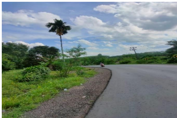
Gambar 5 11 Tikungan Tajam Dengan Sudut Kemiringan
