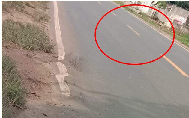
Gambar V. 10 Marka Jalan Pudar
