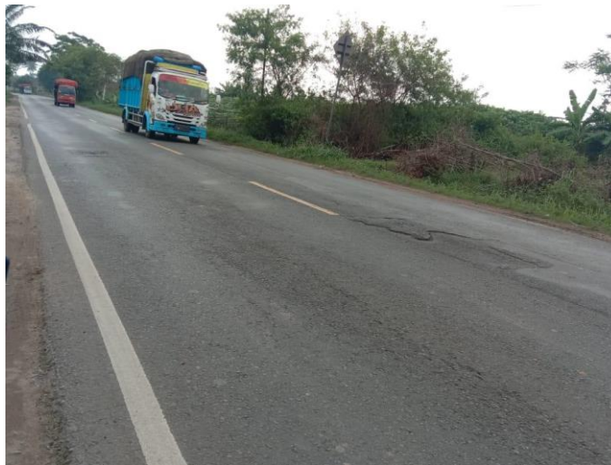
Gambar V. 4 Jalan Berlubang dan Bergelombang
