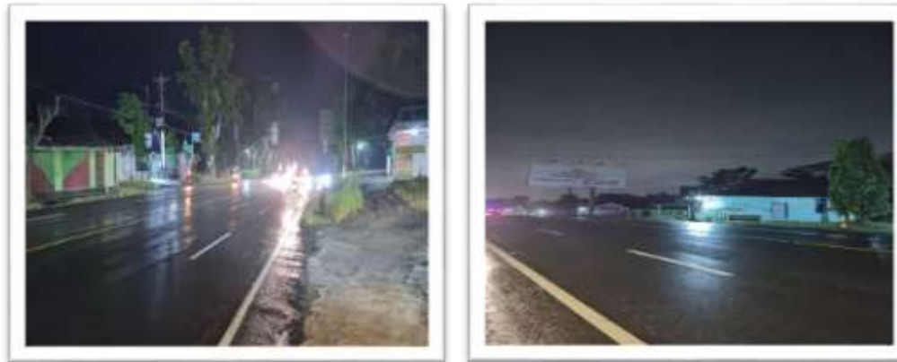
Gambar V. 43 Tidak terdapat lampu penerangan jalan pada segmen 1 dan 2
