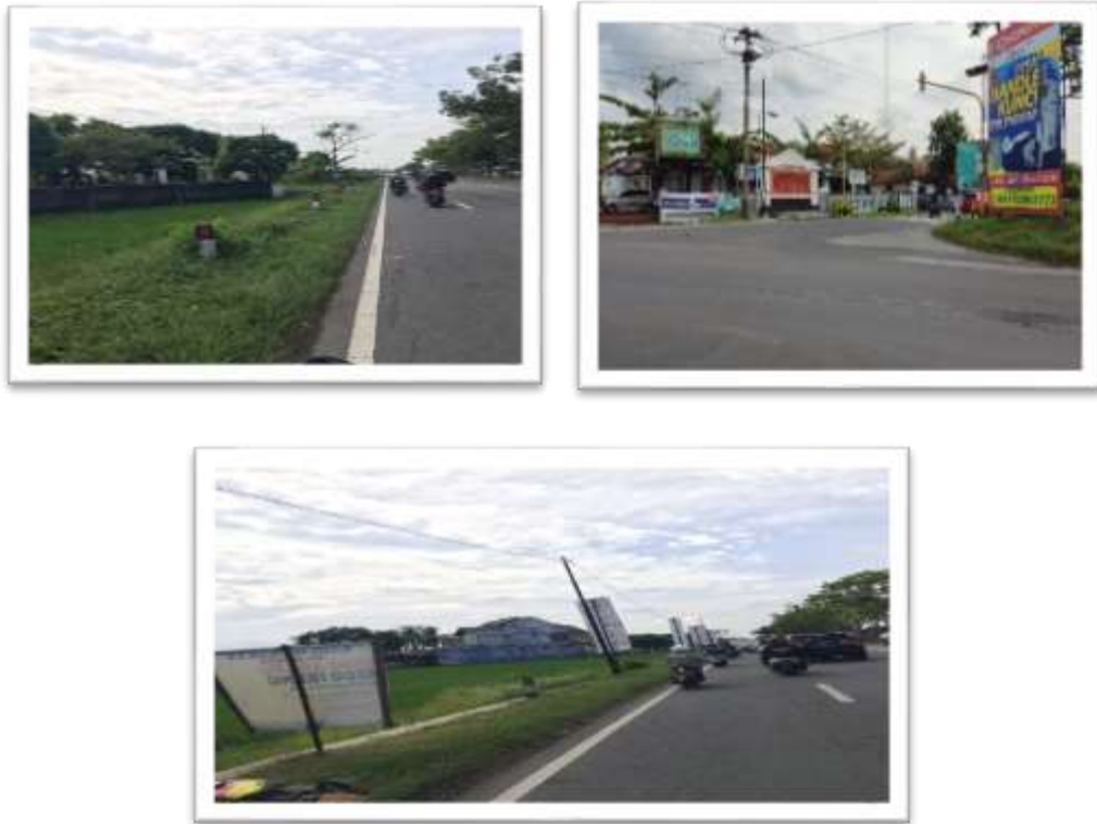
Gambar V. 23 Kondisi Eksisting Tiang Listrik Jalan Wates – Yogya Km 9,6 s/d km 12
