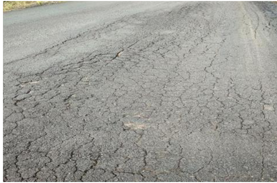
Gambar III.1 Retak Kulit Buaya
