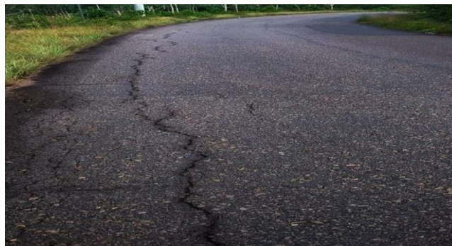
Gambar III.6 Retak Memanjang
