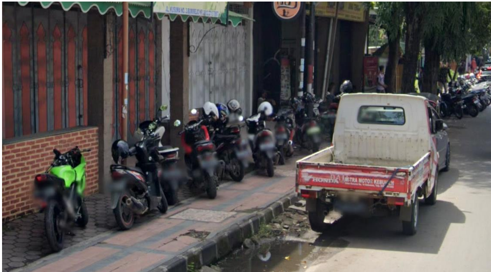
Gambar II. 11 Kondisi Fasilitas Pejalan Kaki di Jalan Kusuma Segmen 1
