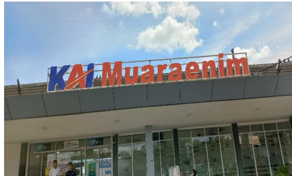
Gambar II. 12 Lampu Penerangan di Stasiun Muara Enim
