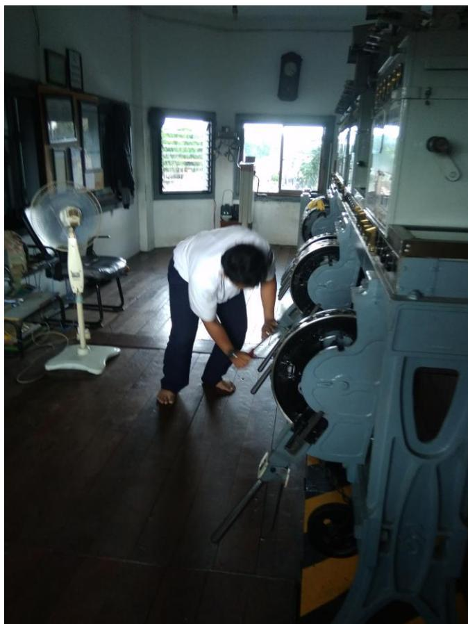
Gambar.V. 1.Peralatan persinyalan mekanik S & H
