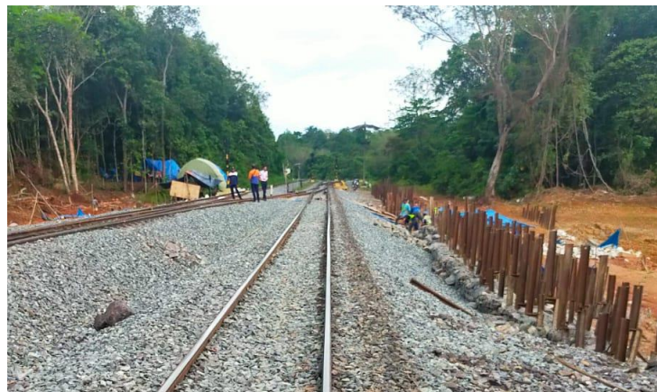
Gambar V. 11 Pemancangan Trুক Rel
