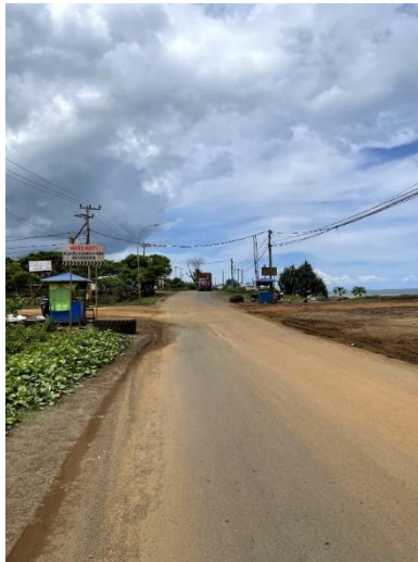
Gambar II.4 Kondisi Permukaan jalan
