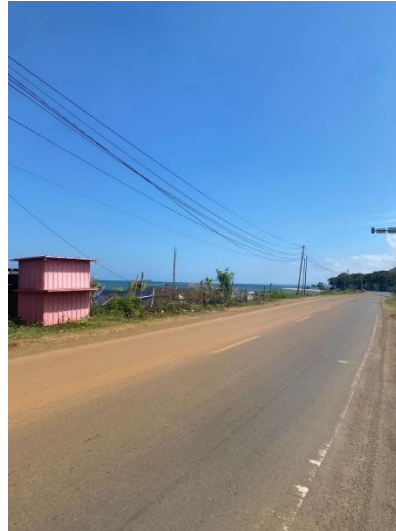
Gambar II.5 Kondisi jalan tidak terdapat pita pengaduh dan rambu
