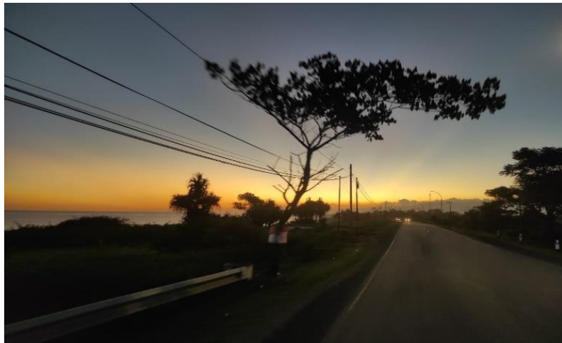
Gambar II.8 Kondisi Jalan Yang Tidak Terdapat PJU
