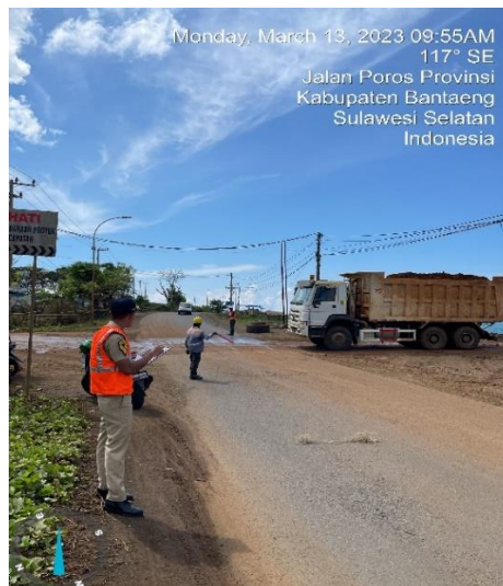
Gambar II.6 Kondisi jalan yang dilewati aktivitas kendaraan tambang
