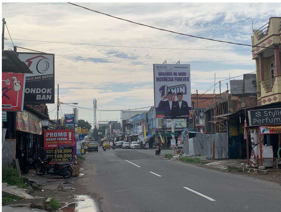
Gambar II.7 Kondisi Fasilitas Pejalan Kaki Pada Ruas Jalan Depan Stasiun Karawang
