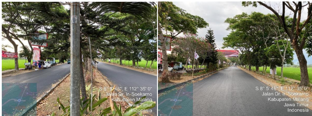
Gambar 2.3 Kondisi Eksisting Ruas Jalan Lingkar Barat Kepanjen
