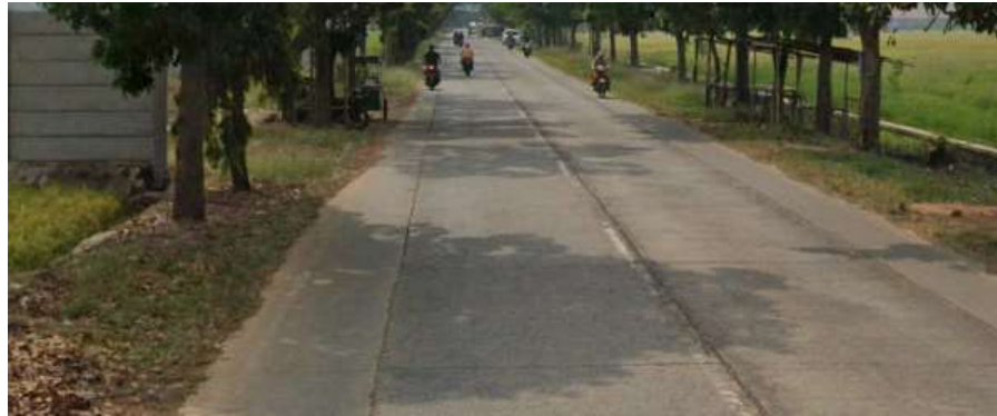
Gambar 2. 11 Kondisi Saat ini Segmen 3
