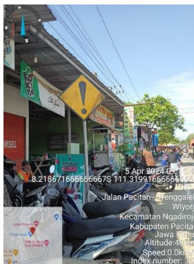
Gambar II. 8 Kondisi Rambu Di Ruas Jalan Bts. Kab. Pacitan – Trenggalek 9
