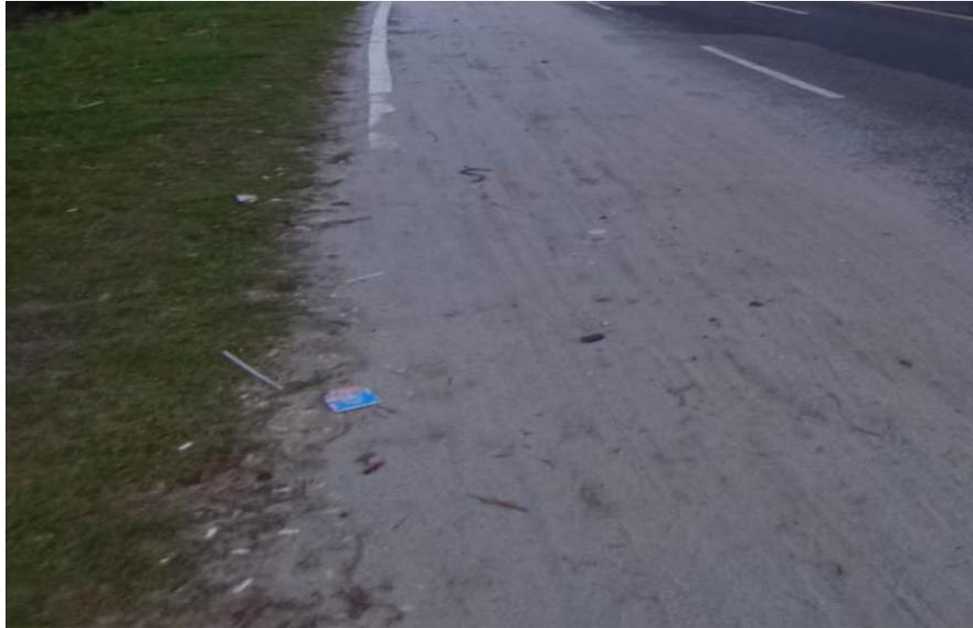
**Gambar II. 5** Kondisi Bahu Jalan Yang Tertutup Oleh Pasir
