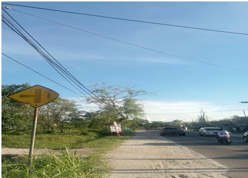
**Gambar II. 6** Kondisi Rambu Jalan Yang Memudar dan Berkarat
